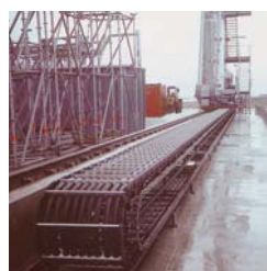
Catena tipo BS 3500 con carro di supporto applicata su impianto di De Icing presso l'aeroporto di Monaco di Baviera.
